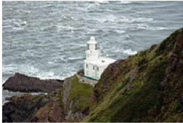
Imagen nº 1: Hartland Point Lighthouse. Autor: desconocido.
