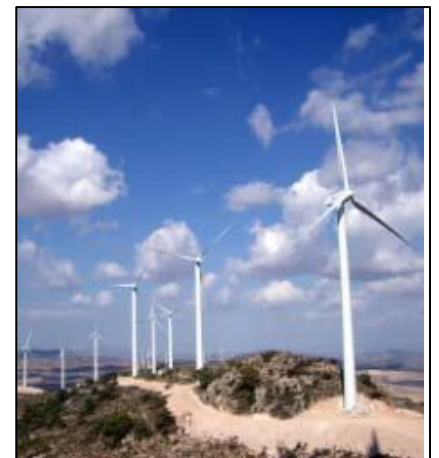
Imagen 4: Parque eólico. Fuente: Materiales Virtuales ESPA LOE
